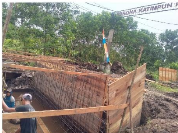
Pembangunan jembatan box curvert di Komplek Pesona Katimpun RT 008 Palangka Raya
